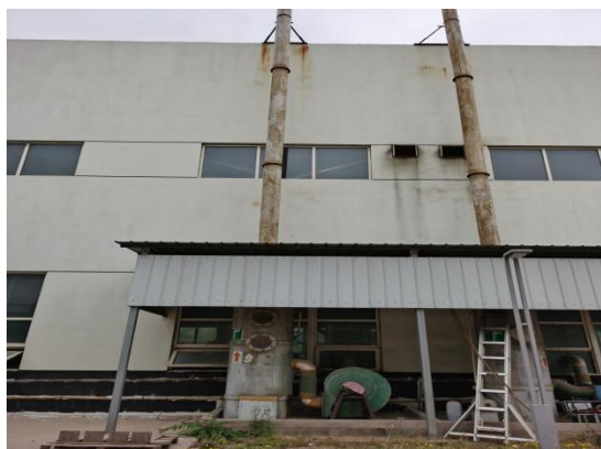
加工区废气排放
